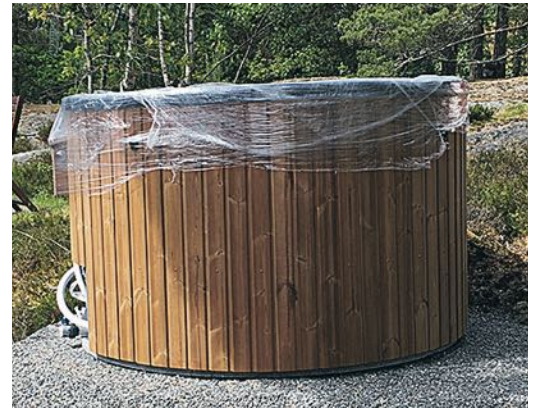
Badet kommer färdigt att sättas på plats och sedan behöver du koppla ihop slangarna.
