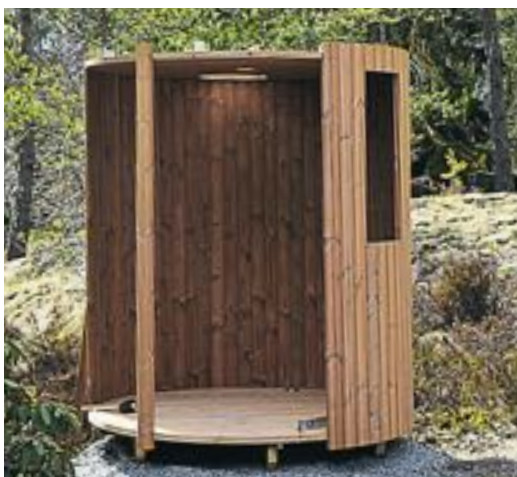
När alla regler är på plats fästs konstruktionen ihop upptill och nertill med ett stålband. Sedan är det bara att sätta på yttertaket och montera bastubänkarna, kaminen och skorstenen.
