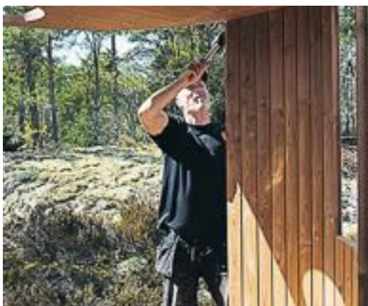
Bastutunnans konstruktion påminner om en tunna, där reglarna slås ihop med en gummiklubba.
