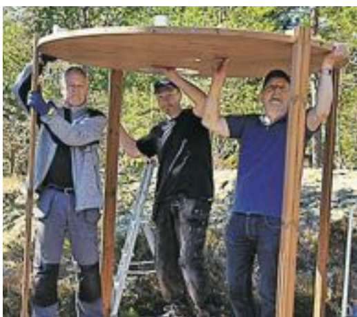
En person bygger lätt ihop bastutunnan, förutom när taket sätts på regler, då behöver man vara fler.
