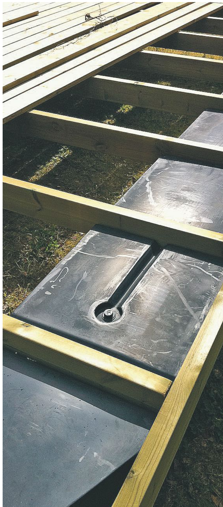
Fäst reglarna i de färdiggjutna balkinfästningarna och lägg på trallen – Enklare kan det inte bli!
