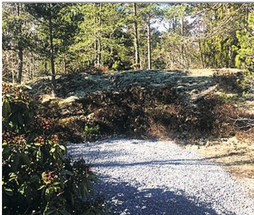
Välj ut en lämplig plats där du gör ett plant fundament för bastun av makadam.
